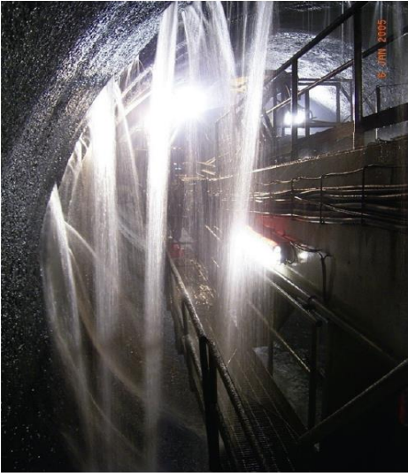
Αιφνίδια εισροή νερού σε σήραγγα TBM (Ισλανδία)
